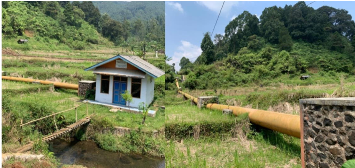
Gambar 1. Pembangkit Listrik Tenaga Mikrohidro Tangsijaya
