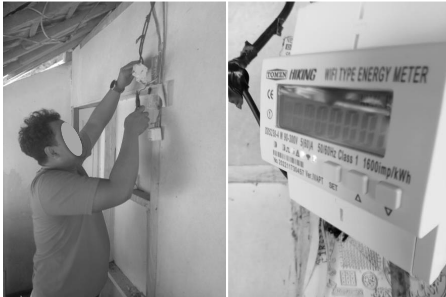
Gambar 6. Pemasangan Alat Monitoring PLTMH
