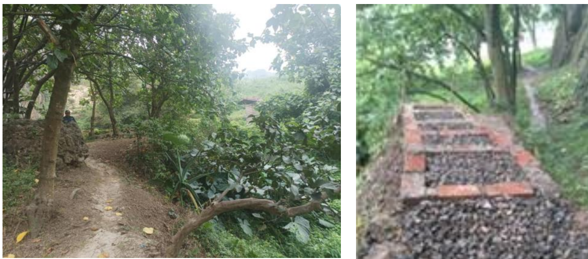
Gambar 6. Akses jalan setapak menuju kawasan area camping ground di Karang Panganten sebelum dan sesudah direnovasi agar tidak mengalami longsor
