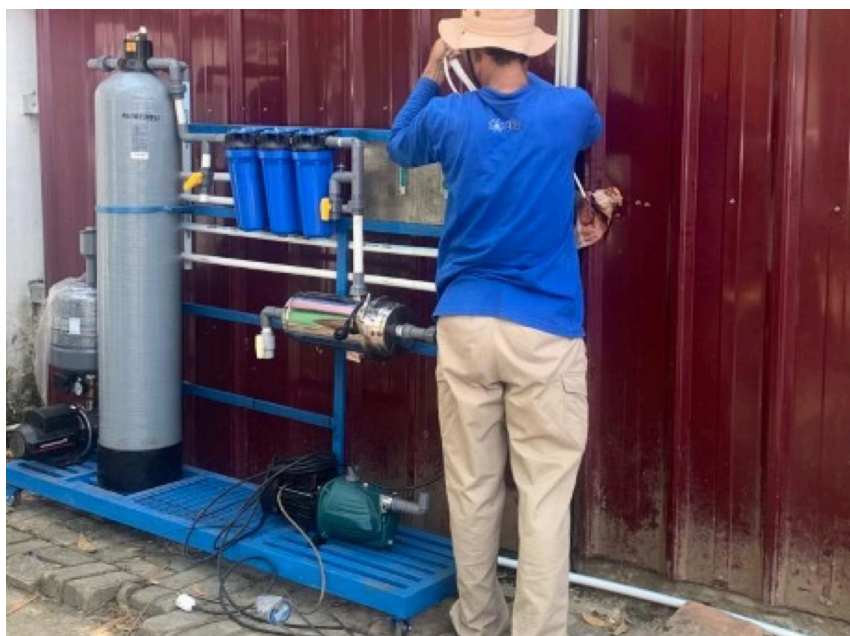
Gambar 3. Instalasi dan Uji trial and error unit kolom gelembung pancaran
