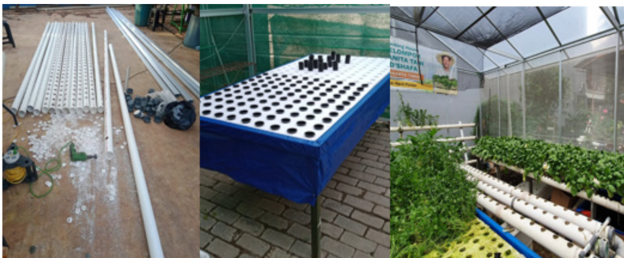
Gambar 3. Pembuatan Instalasi Hidroponik
