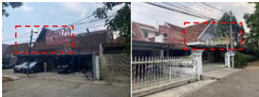
Gambar 5. Rumah Prabudimutur No.14 & 20 (Sumber: Dokumentasi Penulis, 2023)
