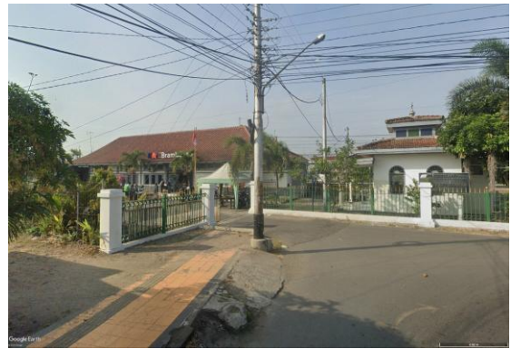
Gambar 10. Stasiun Brambanan, Kab. Klaten (Sumber: Google Street View, 2023)
