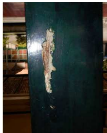
Gambar 7. Kerusakan kolom Pendapa Dalem Mangkubumen
