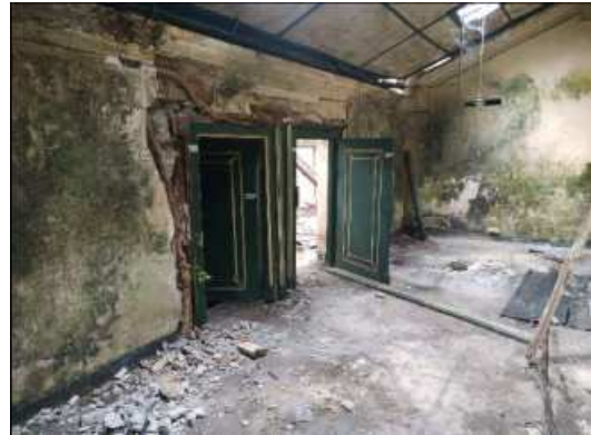
Gambar 6. Kerusakan dinding bangunan Dalem Notoprajan (Sumber: Laporan Pemugaran Rehabilitasi Dalem Notoprajan (Aloysius Wahyu, Prasetyo, & Lukito, 2021)
