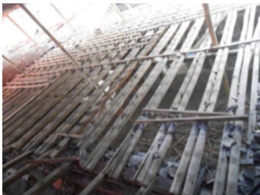
Gambar 5. Kerusakan atap bangunan Dalem Suryowijayan (Sumber: Laporan Arkeologi Rehabilitasi Dalem Suryowijayan (Susanto, Prasetyo, & Sumartono, 2017)
