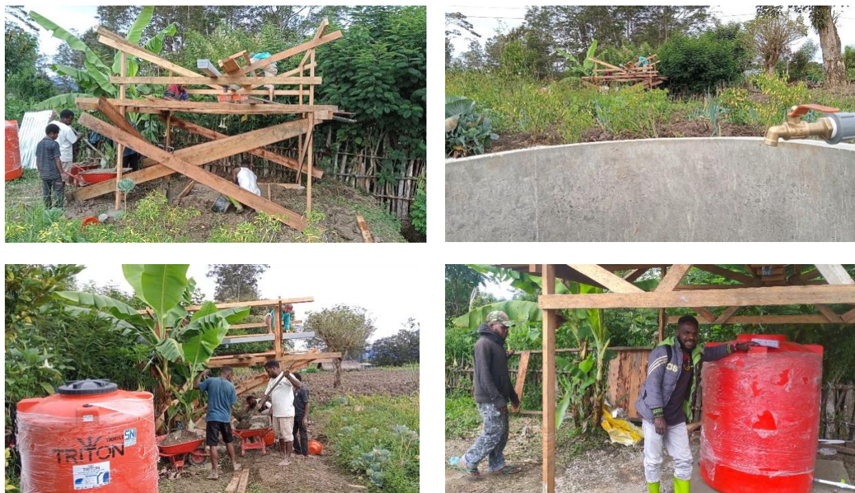
Gambar 6. Perakitan dan Pendirian Bangunan untuk Panen Hujan Sumber: Dokumentasi Pribadi, 2022
