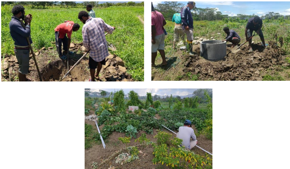
Gambar 5. Penggalian Lubang untuk Penampungan dengan Gorong-gorong Sumur & Pemasangan Instalasi Pipa. (Sumber: Dokumentasi Pribadi, 2022)
