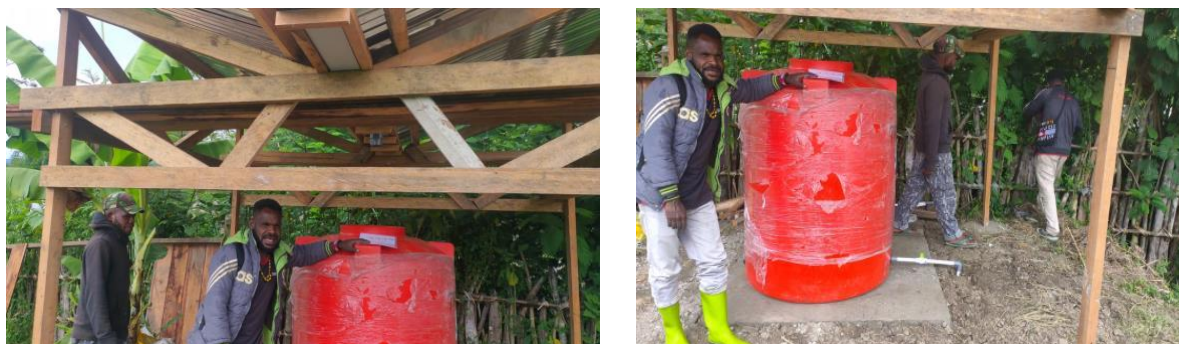
Gambar 7. Bangunan Pemanenan Air
