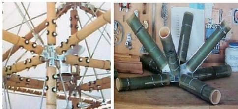
**Gambar 9.** Sambungan bambu modern dengan penggunaan material baja sebagai perkuatan sambungan (Sumber : rwth-aachen, 2002)
