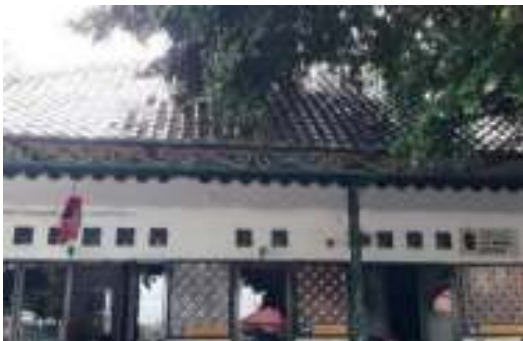
Gambar 4. Bangunan SD Keputran 01 (Sumber: Dokumen Penulis, 2022)
