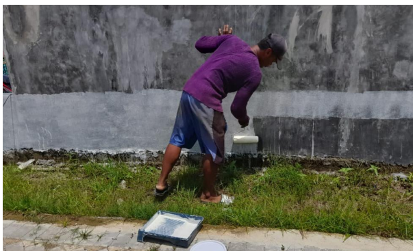
Gambar 10 Proses pengecatan
