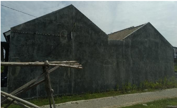
Gambar 9 Kondisi awal lokasi sebelum dicat
