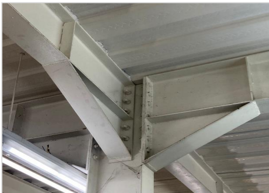
Gambar 1. Sambungan haunch yang populer di Indonesia
