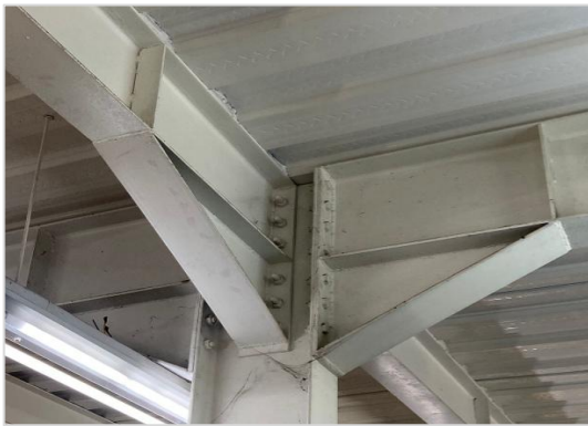
Gambar 1. Sambungan haunch yang populer di Indonesia
