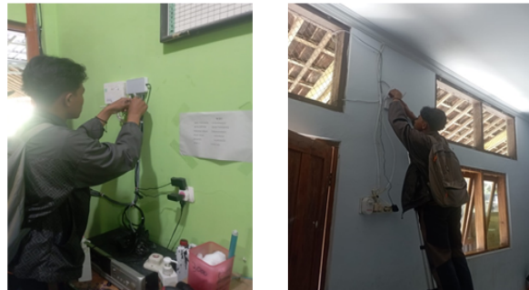
Gambar 4. Pemasangan Router dan Access Poin
