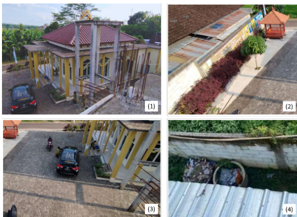
Gambar 3. Permasalahan aspek arsitektural: (1) Menara air masjid yang mengganggu sirkulasi; (2) Akses masuk yang terlalu curam; (3) Keterbatasan lahan membuat lahan parkir dan bermain menjadi satu; (4) Belum ada pengolahan sampah secara terpadu.
