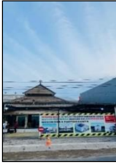
Gambar 2. Kondisi Masjid Nur Mirah Serengan Surakarta (Sumber: dokumen pribadi 2023)
