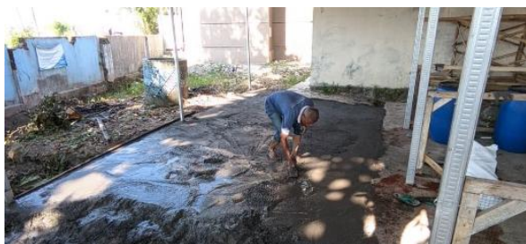
Gambar 24. Hasil Pengawasan Pengerjaan Lantai Beton Rumah Sampah Anorganik
