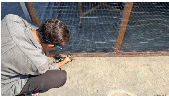
Gambar 26. Hasil Pengawasan Pengerjaan Sekat dari Kayu dan Jaring Baja Rumah Sampah Organik
