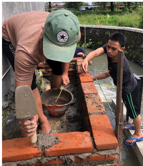
Gambar 8. Proses Pembuatan Bak Air
