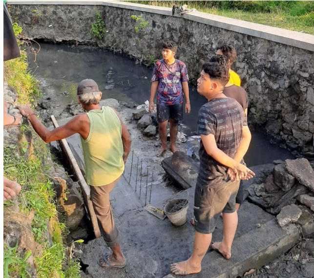
Gambar 4. Proses Pembuatan Pondasi
