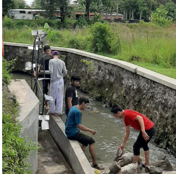
Gambar 7. Proses Penyetingan Kincir Air
