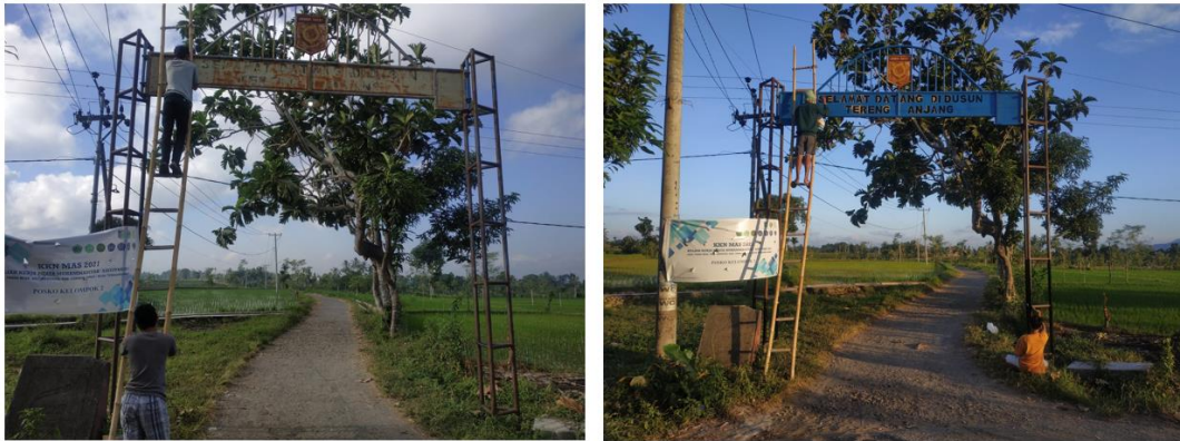
Gambar 6. Pengecatan gapura Dusun Tereng Anjang
